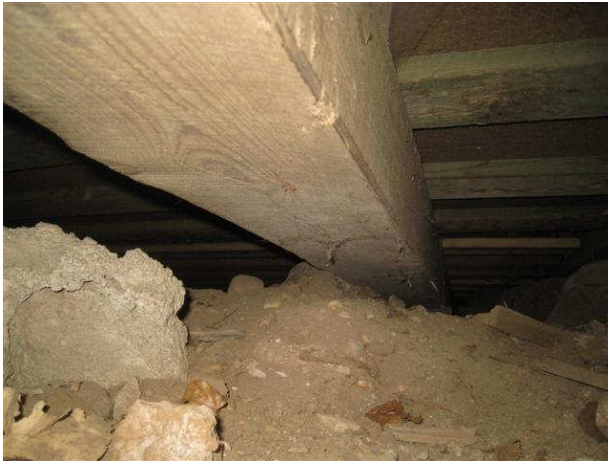
Kuva 9 Alapohjaa keskialueella, kestopuuparuruja ja bituliittia.
