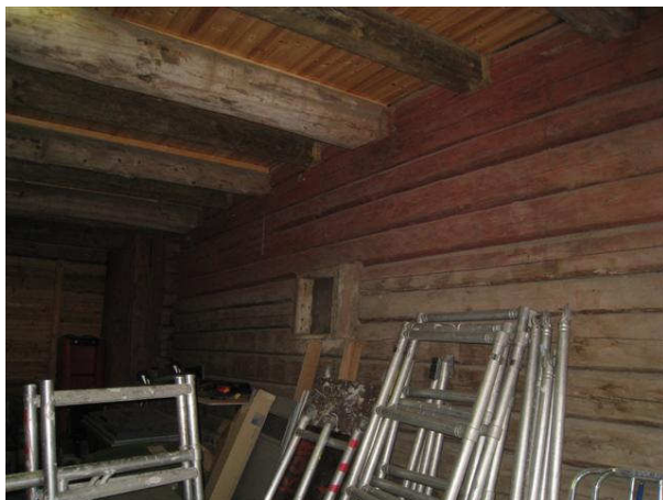
Kuva 71 Lantalan kohdalla olevia välipohjarakenteita.
