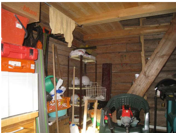
Kuva 53 Uusittu välipohjarakenne keskiaitassa.
