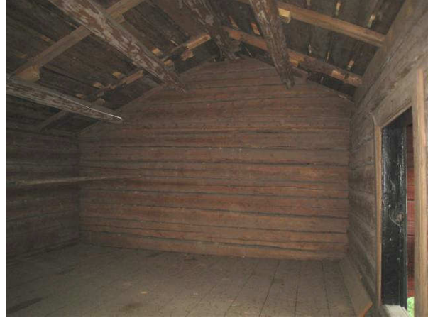
Kuva 56 Länsipäädyn yläkerran aitta.
