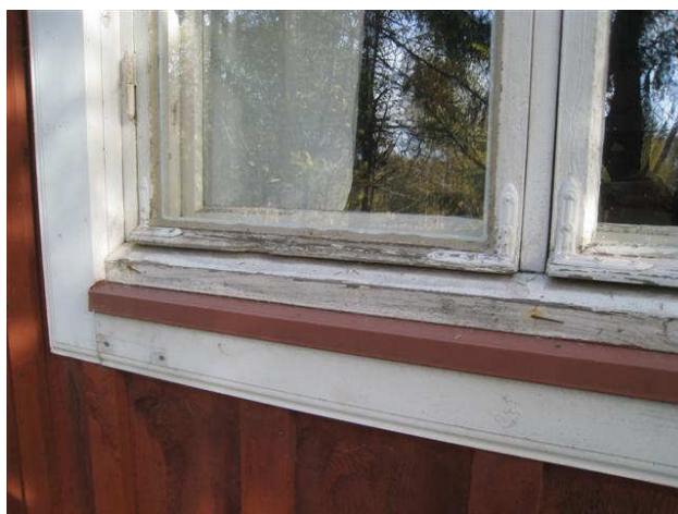
Kuva 18 Vesipellititys suojaa vain pielilaudotusta.
