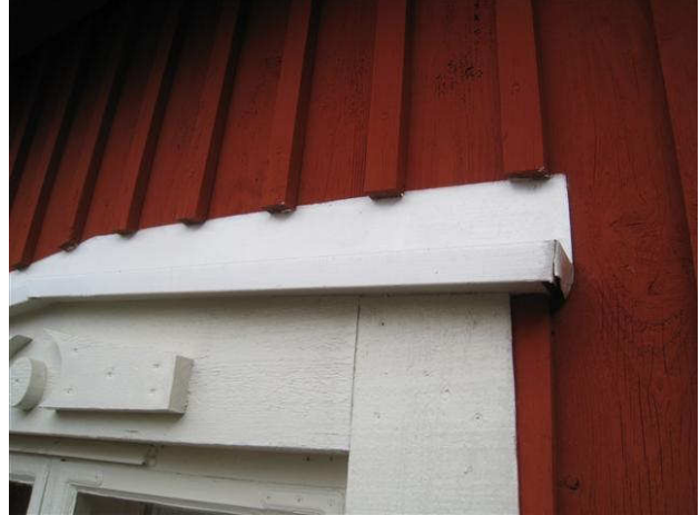
Kuva 38 Ikkunan yläpielen suojaus.
