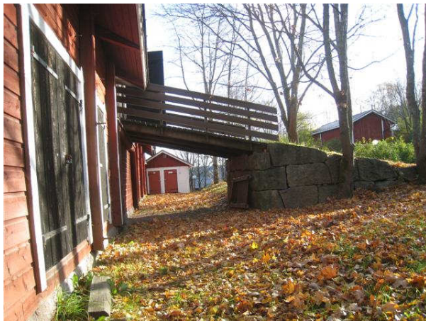
Kuva 59 Maasto viettää kohti navetan eteläsivua.
