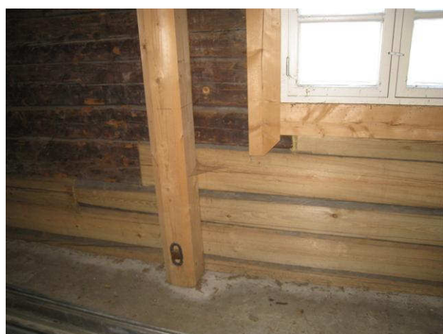
Kuva 66 Uusittuja hirsiiä ja vöjari navetassa.
