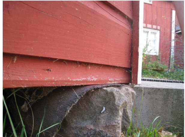
Kuva 36 Kuistin perustuksena ovat irtokivet, välissä on bitumikermi.
