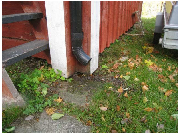
Kuva 50 Matala perustus ja kattosadevedet jäävät talon viereen itäpäädyssä
