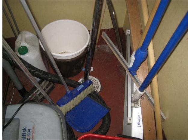
Kuva 26 Siivouskomerossa on muovimatto vedeneristeenä ja lattiakaivo.
