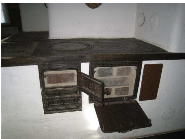
Kuva 23 Umpeen muurattu tulisijan luukusto länsipäädyn tuvassa.
