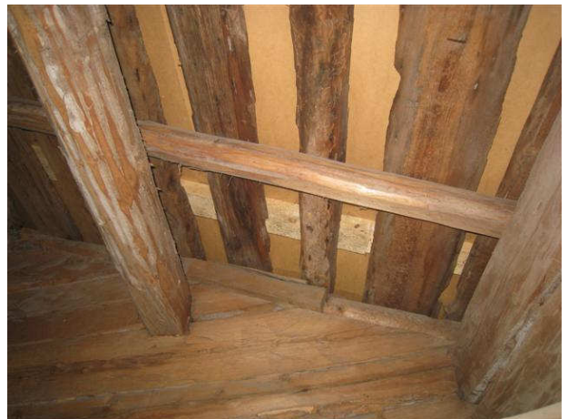
Kuva 54 Osin uusittu kattorakenne, katteen alla on aluskate.
