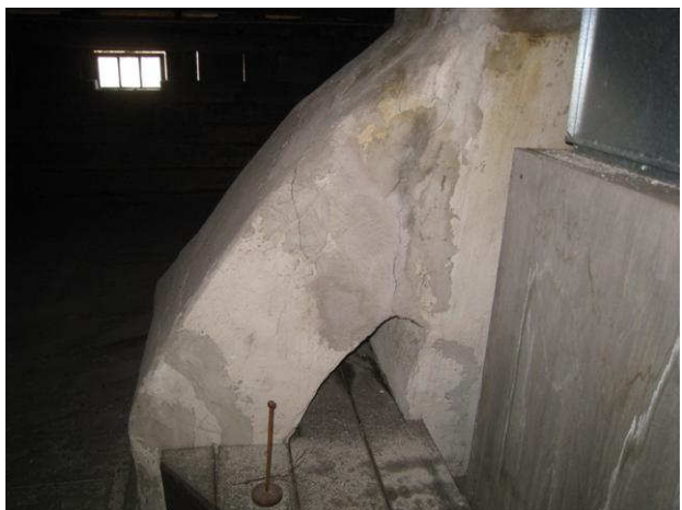
Kuva 24 Ullakon savuhormiratkaisu ja IV-kanavaa.
