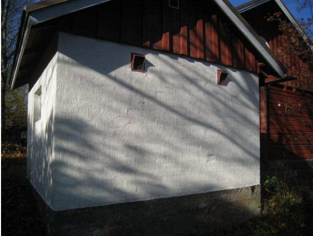
Kuva 61 Wc- ja jätetila, perustus on betonia, seinät on muurattu.
