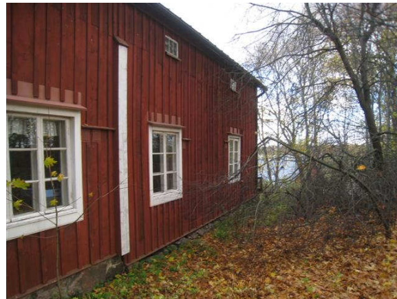
Kuva 4 Eteläisivulla maa viettää kohti rakennusta
