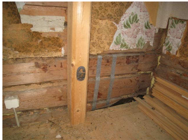
Kuva 20 Uusittu völjari ja teräspantoja hirsien tukena.
