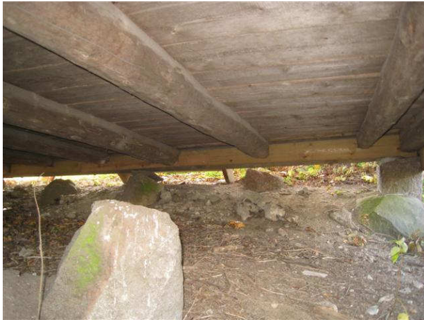
Kuva 49 Perustus, lattia ja parrut ovat ok.
