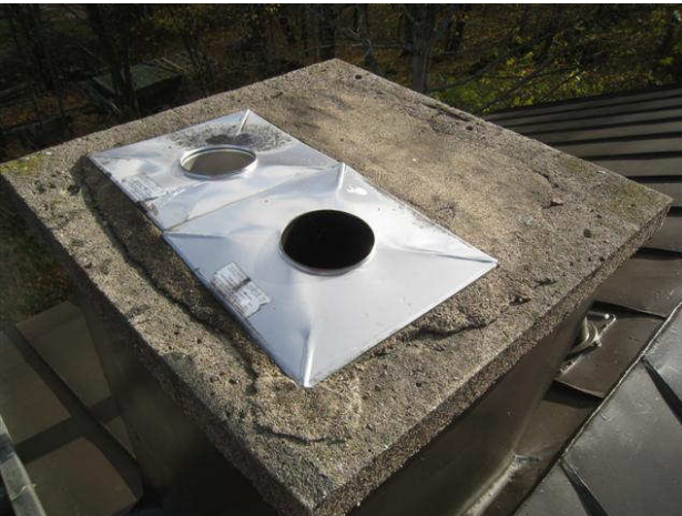
Kuva 41 Piipun pää on kattamatta, savuhormit ovat rst-sisäpiippuja.
