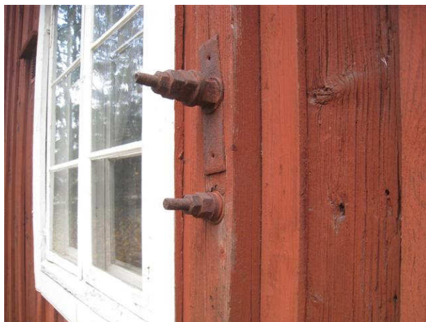
Kuva 14 Völjarin pulttauksia
