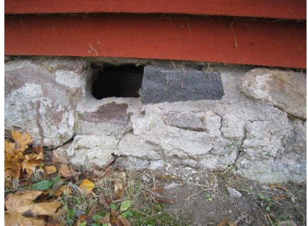
Kuva 34 Sokkelin tuuletusaukko.
