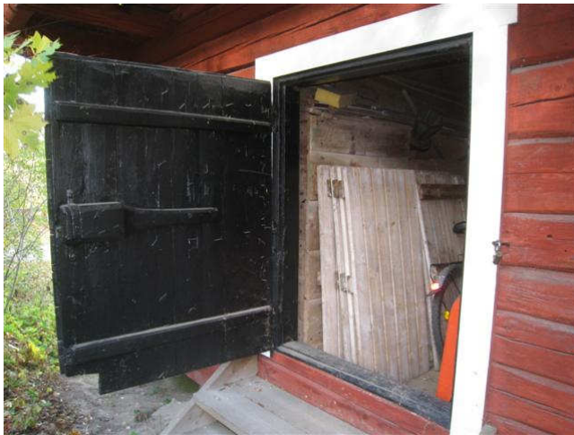
Kuva 57 Alkuperäinen tai ainakin vanha ovi on kunnossa.
