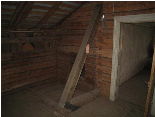
Kuva 21 Ullakon hirsirungon vinotuki. Vesikatteen alla ei ole aluskatetta.
