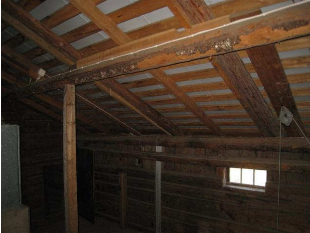
Kuva 19 Ullakon keskialueen kattorunko vaikuttaa heikolta.
