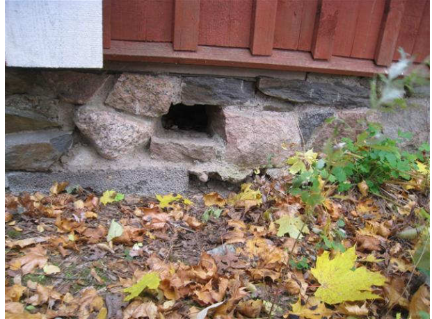
Kuva 8 Tuuletusaukko ja ksh-muurausta
