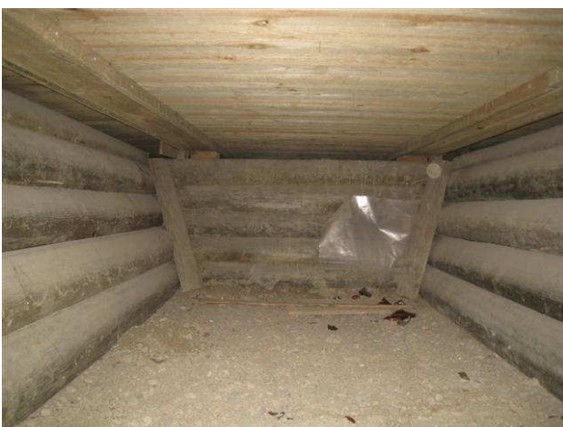
Kuva 11 Itäpäädyn salin alla oleva kellarisyvennys, seinät ovat kestopuupylväitä.
