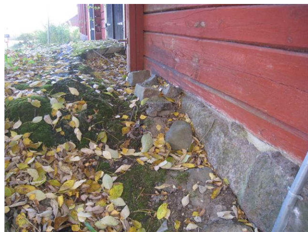
Kuva 64 Tästä maanpintaa on leikattava pohjoissivun länsipäädyn lähellä.
